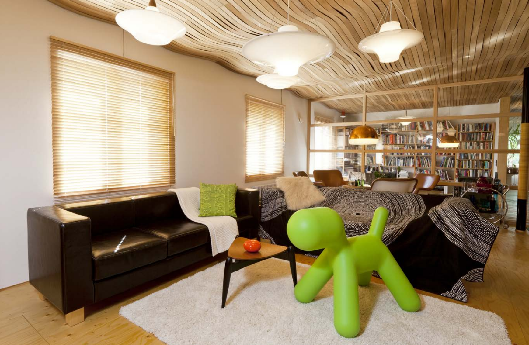
Olohuoneen katto tehtiin parkettitehtaan tuotantoon kelpaamattomasta, virheellisestä irokosta, joka on afrikkalainen puulaji. Arto sai idean lehtijutusta, jossa oli suomalaisarkkitehdin suunnittelema huoneisto Pariisissa. Siinä oli puurimasta tehty samanhenkinen, aaltoileva katto. Myös viereisen sivun kuva on olohuoneesta.
