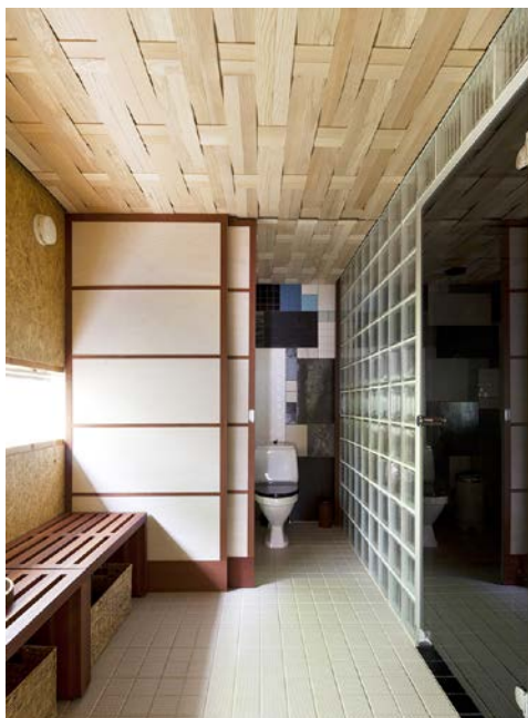
Saunaosastolla on Arton suunnittelema korinpunos-katto. Se on vaihtoehto paneelikatolle.
